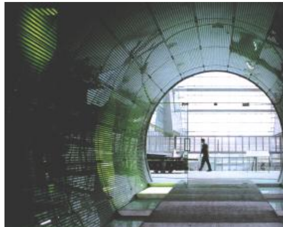
Eingang – Blick ins zentrale Atrium
