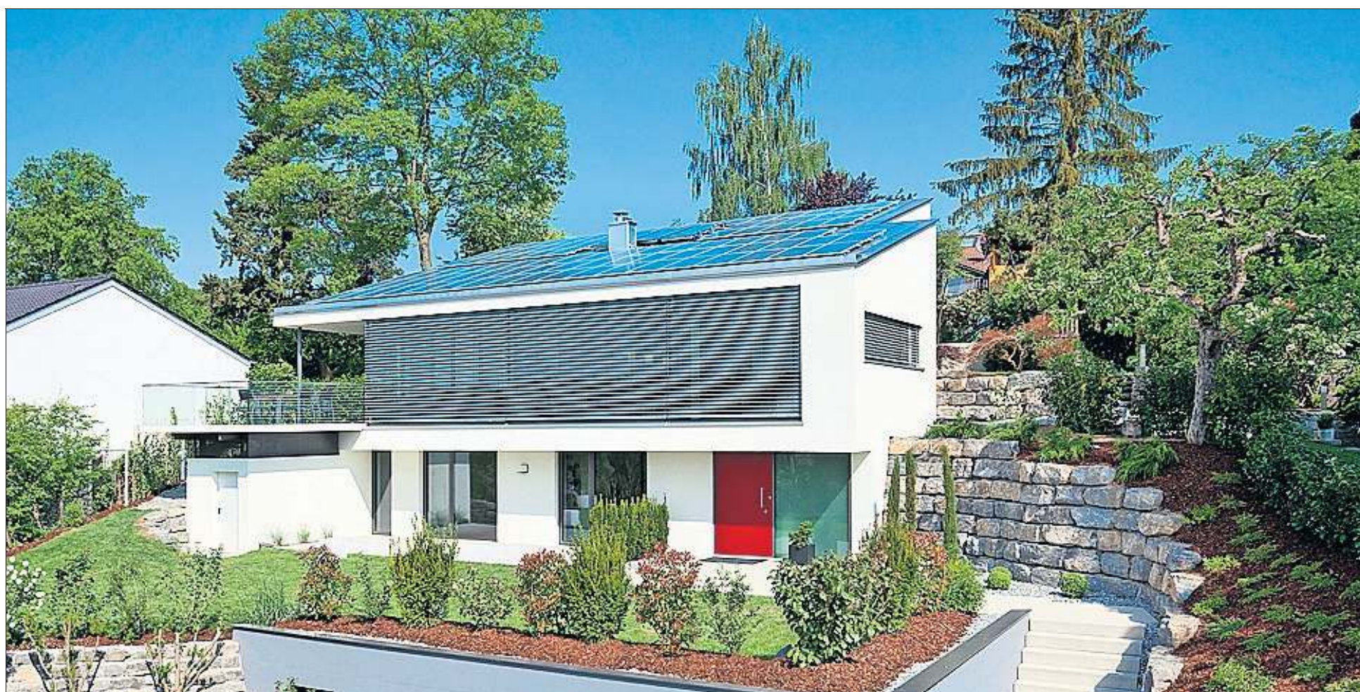
Erzeugt seit 2010 seinen Strom selbst, versorgt zwei E-Autos und gibt Überschussenergie ins Netz: Das Plus-Energie-Haus in der Berghalde in Warmbronn
