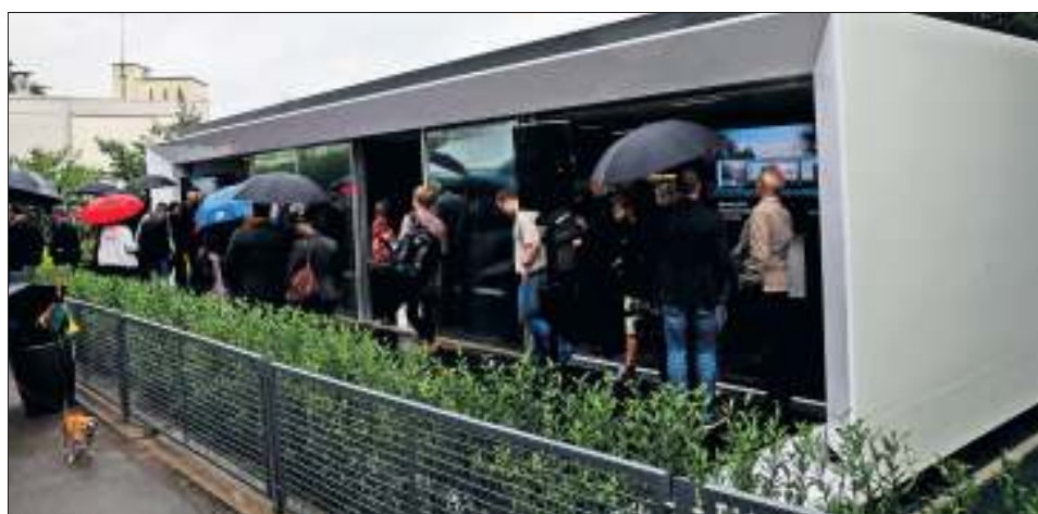
Erzeugt seit 2014 seinen Strom selbst, versorgt zwei E-Autos und gibt Überschussenergie ins Netz: Das Aktivhaus auf dem Killesberg
